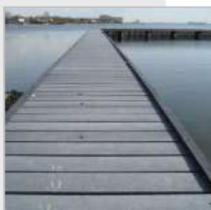
Attraverso l'uso di travi di plastica rinforzate in acciaio è possibile costruire pontili o ponti con molta più luce. Ciò significa che, in contrasto alla costruzione tradizionale, è necessario un minor numero di pali. Ciò consente di risparmiare costi di materiale e di costruzione.
