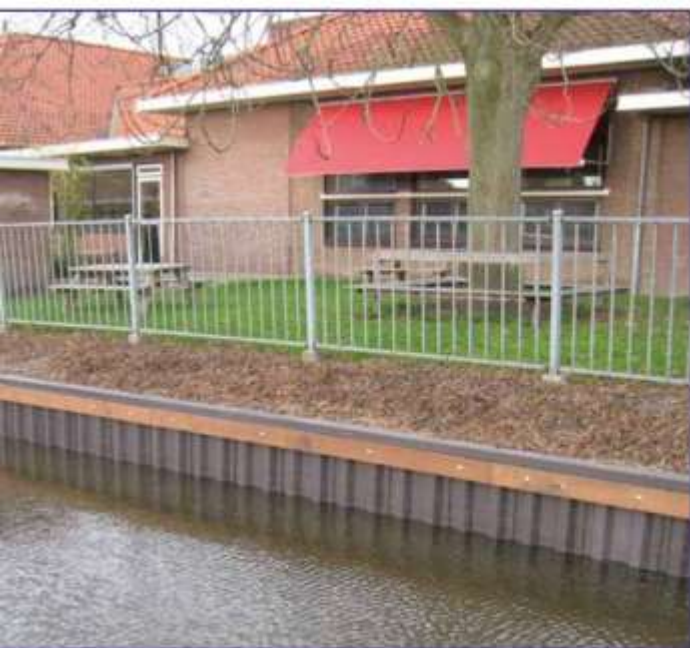
Le palancole in materiale plastico sono dotate di uno strato superficiale color marrone scuro, resistente all'usura e dotato di una protezione UV unica. Questo garantisce al prodotto una vita di almeno 50 anni.
